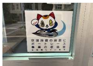
空調設置状況 (西浦北小学校)
