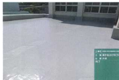
常滑東小学校(改修後)
