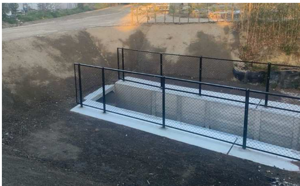
排水路整備工事(R7新田)
