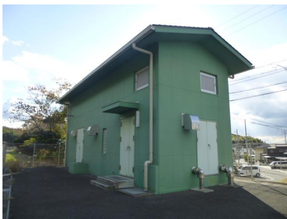
飛香台ポンプ場
