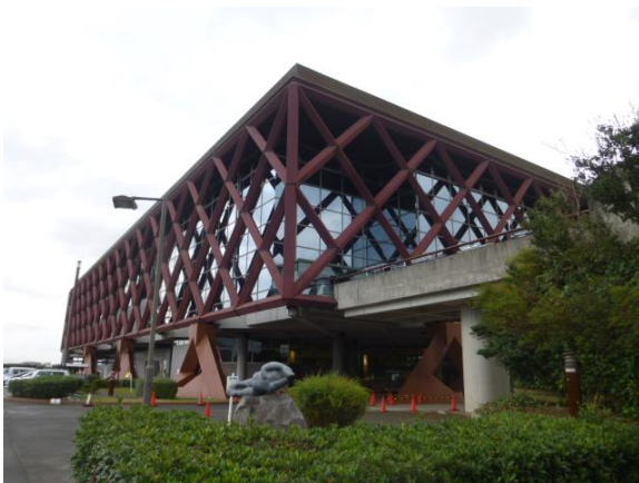
重要給水施設（常滑市体育館）
