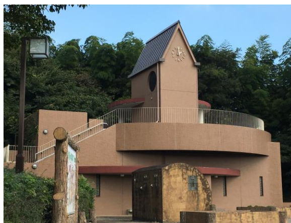
松原ポンプ場
