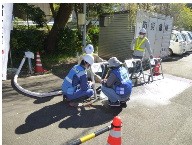
訓練：応急給水栓と仮設給水栓（蛇口）と連結
