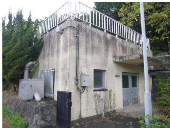
大曽ポンプ場
