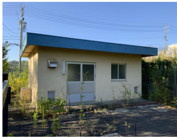
御林ポンプ場
