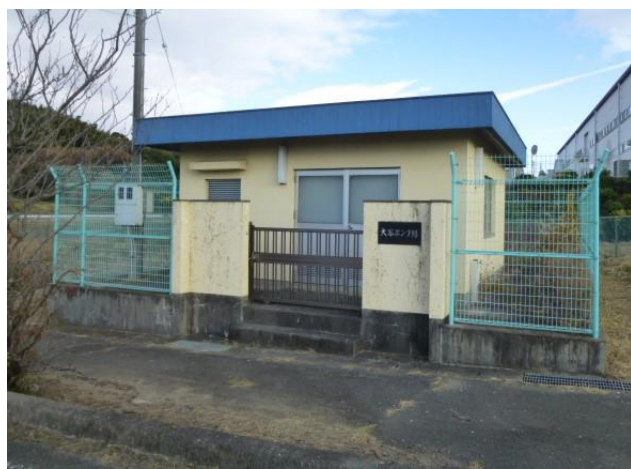
大谷ポンプ場
