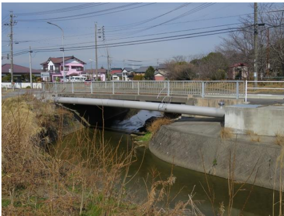
水管橋（久米配水区）
