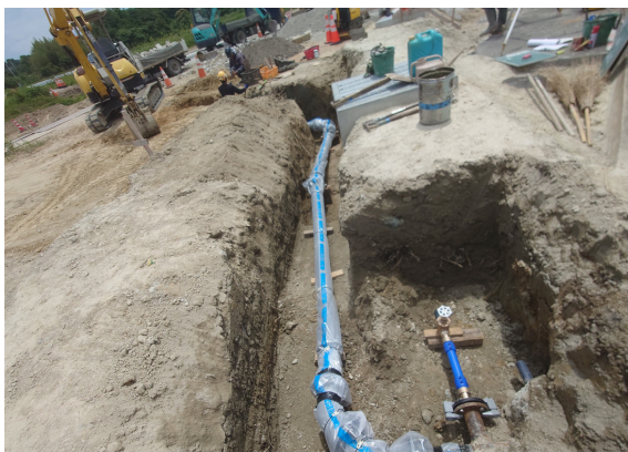
水道管布設工事の様子
