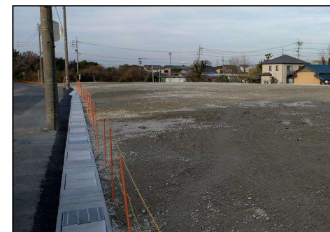
現場写真①
