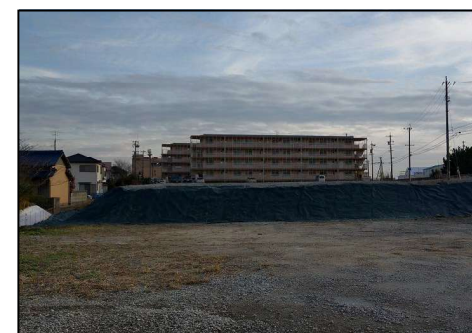
現場写真①
