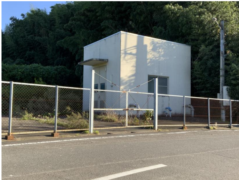
前天神ポンプ場 2025.4月ポンプ停止し自然流下に変更
