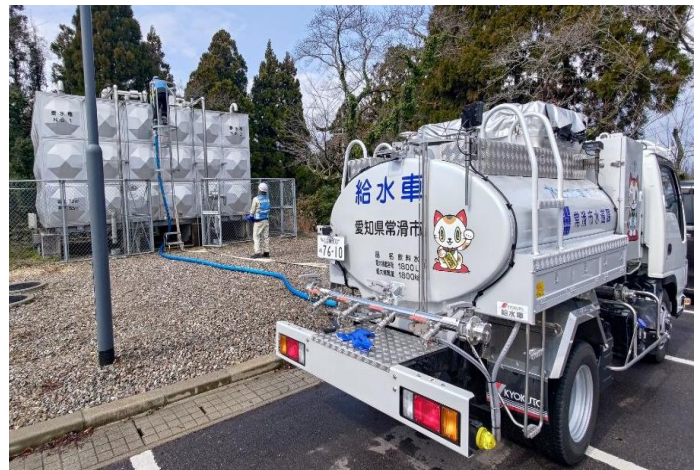
給水車災害支援：石川県の病院・受水槽への加圧給水
