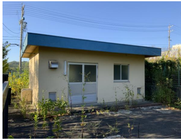
御林ポンプ場
