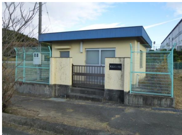
大谷ポンプ場
