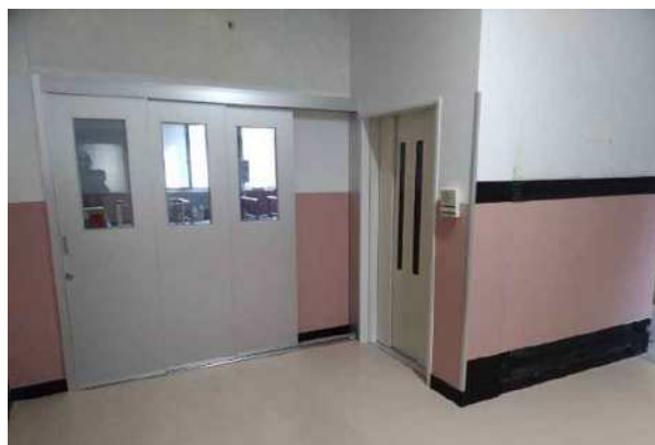
南陵中学校エレベーター改修工事(改修後)
