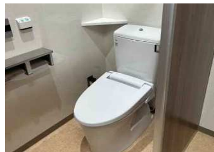
和式トイレを洋式に改修
