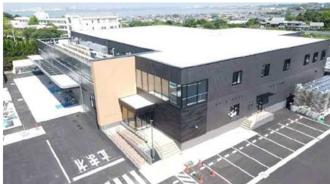
給食センター完成写真
