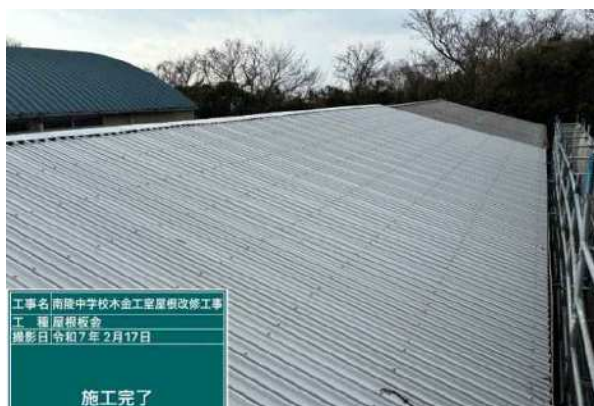
南陵中学校木金工室屋根改修工事(改修後)
