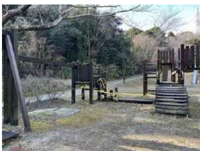
桧原公園 改修前
