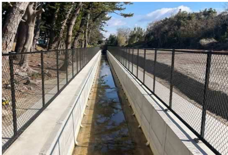
排水路整備工事(R6新田)
