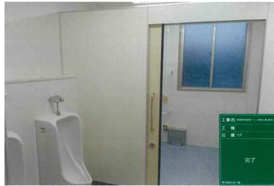
鬼崎柔剣道場トイレ(改修後)
