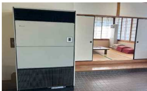
待合ホール・和室のエアコン更新
