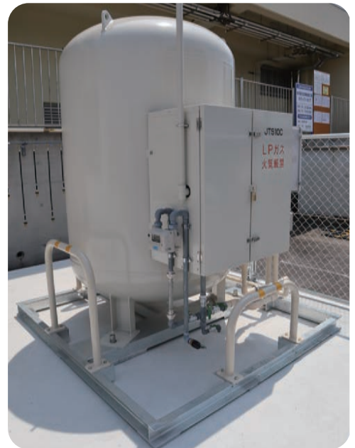
(上) 室外機 (右) LPガス貯槽
