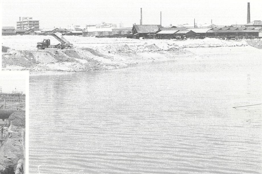
鯉江新開公有水面埋立工事 (昭和36年)
