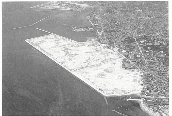
保示・樽水公有水面埋立工事完成(昭和37年)
