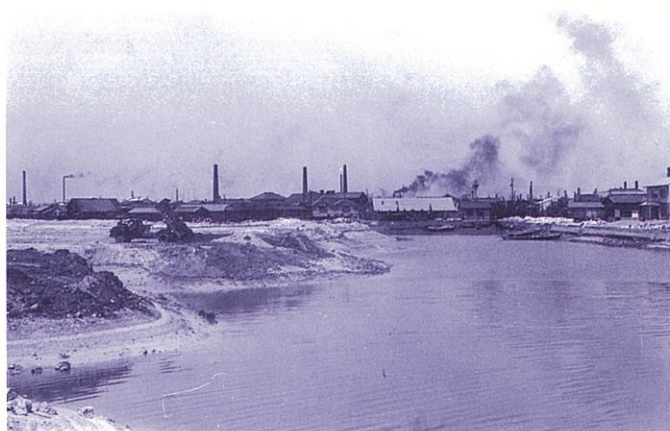
鯉江新開公有水面埋立工事(昭和32年)
