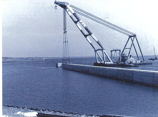
常滑港港湾区域内公有水面埋立工事(平成 5 年)
