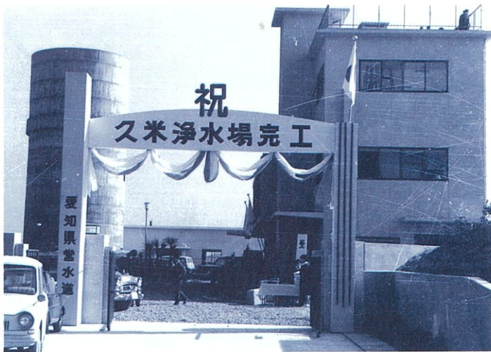
久米浄水場完成(昭和36年)
