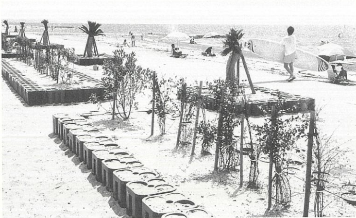
多屋海岸に花壇の擁護壁完成(昭和63年)
