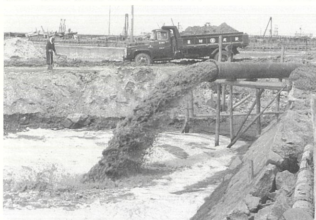
保示・樽水公有水面埋立工事(昭和36年)
