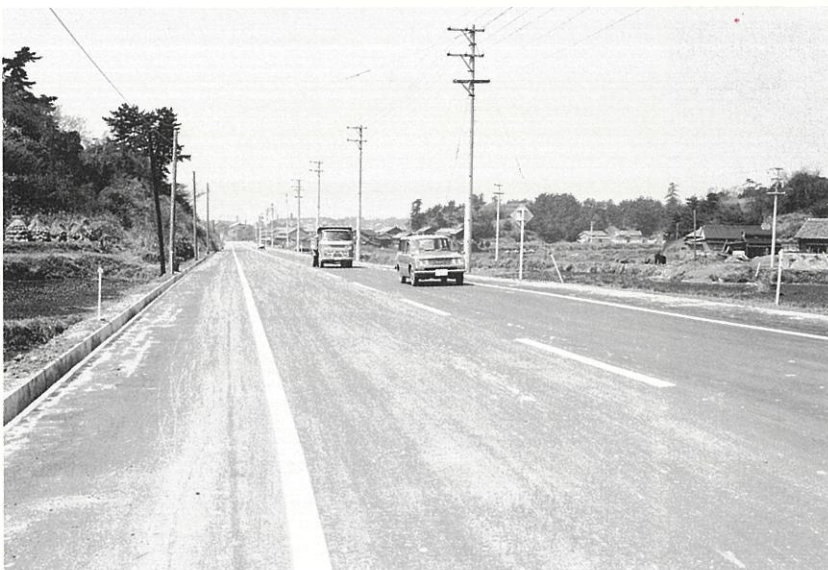
環状1号線全線舗装(昭和43年)
