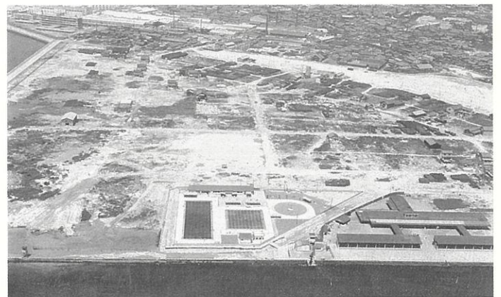
市営プール完成(昭和37年)
