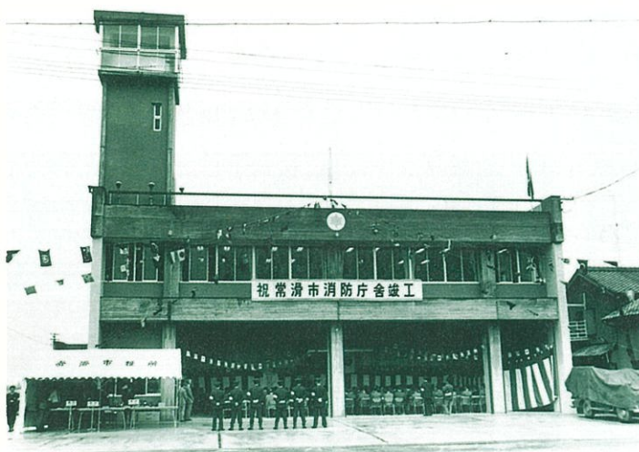
消防庁舎完成(昭和40年)
