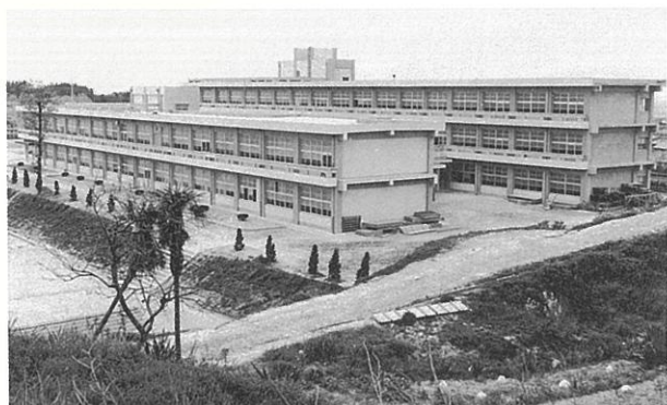
南陵中学校 3 期工事完成(昭和41年)
