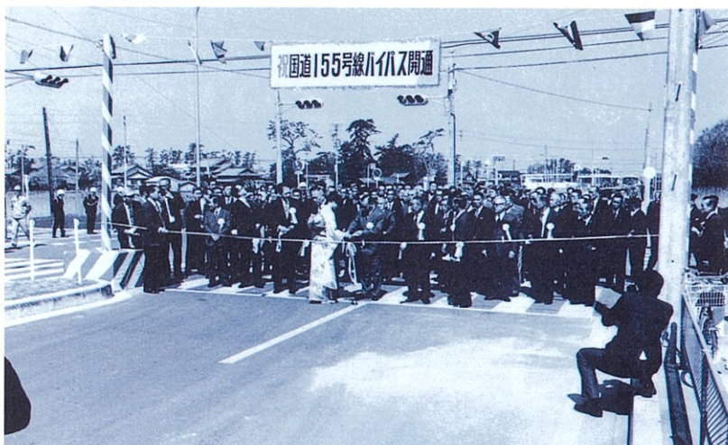
一般国道155号線バイパス開通(昭和49年)
