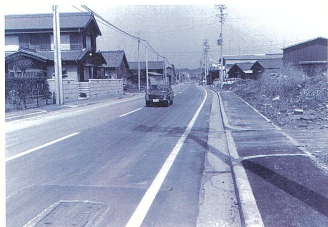
常西線街路事業完成(昭和46年)
