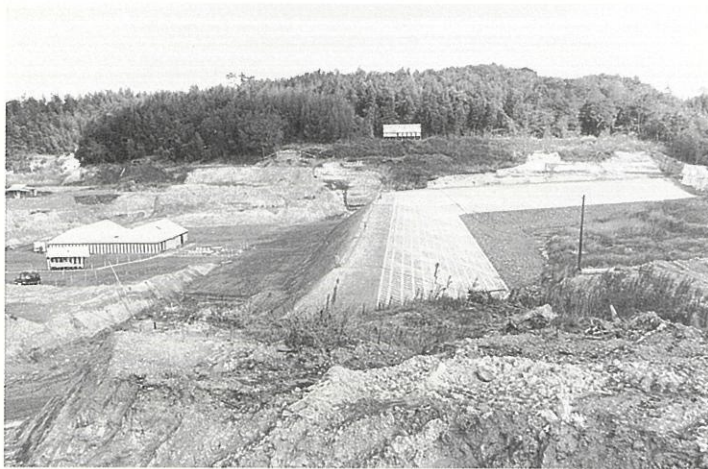
前山ダムの本堤工事(昭和60年)
