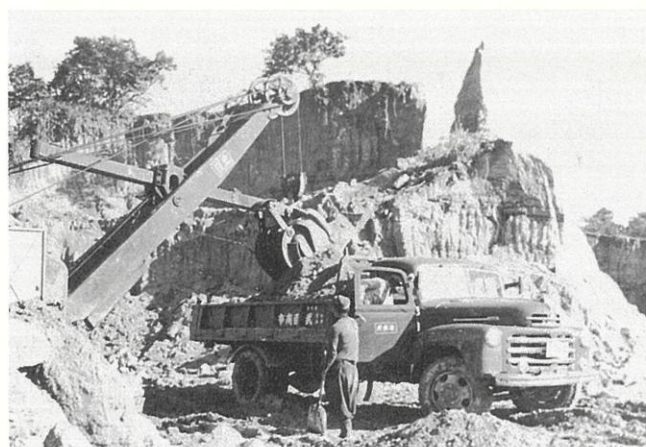
杜辺採土現場(昭和32年)
