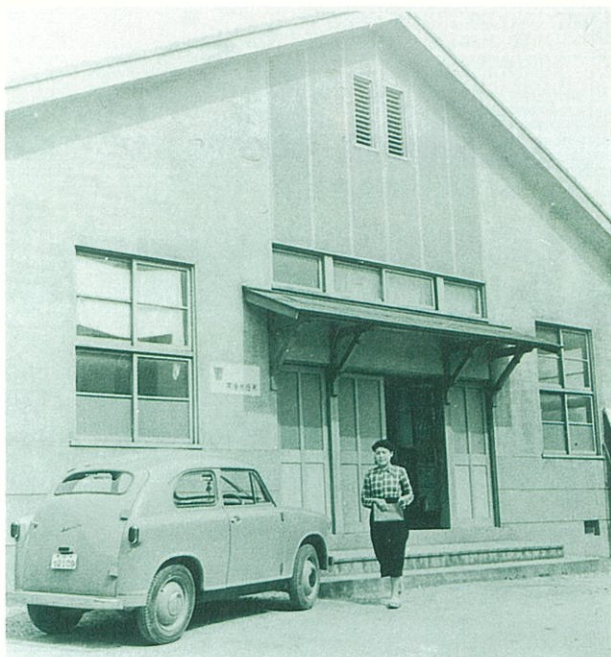
市役所新館(昭和32年)
