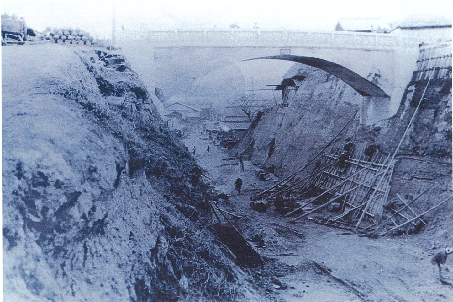
工事中の郡道といちき橋
