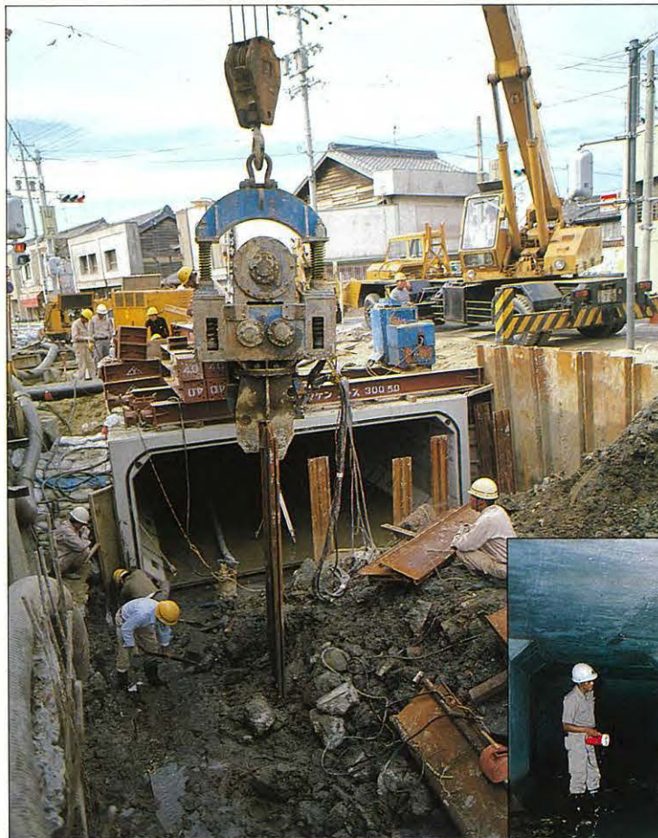
●水路改修工事
