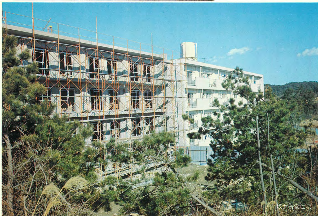
榎戸市営住宅
