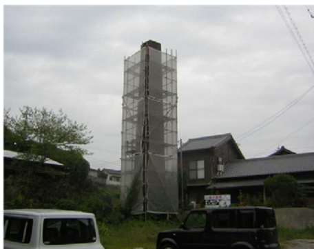
▲改修中の様子
