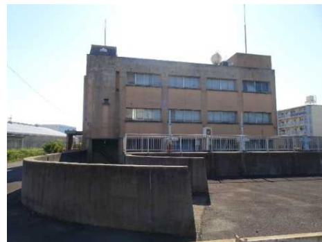
▲榎戸雨水ポンプ場
