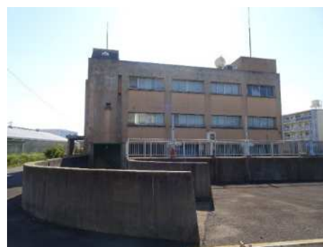
▲榎戸雨水ポンプ場
