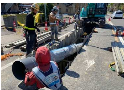
▲配水管の更新・耐震化工事
