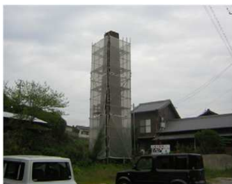
▲改修中の様子
