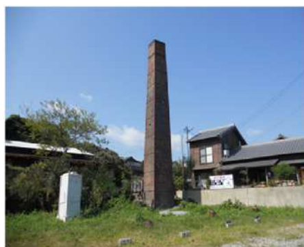
▲改修後のレンガ煙突
