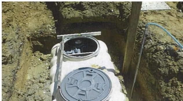
5人槽の合併処理浄化槽
