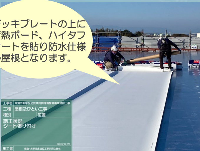
④ 屋根工事（防水シート張り）
