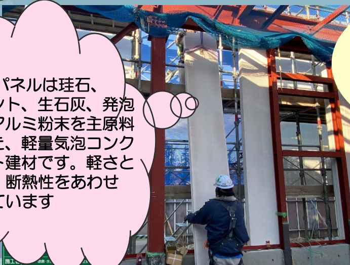
③ 組積工事（ALC建込み状況）
