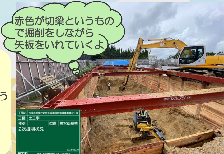
④ 排水処理機械室 掘削状況
