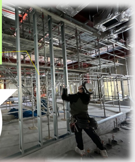
④軽量鉄骨下地建込み→ボード張り
