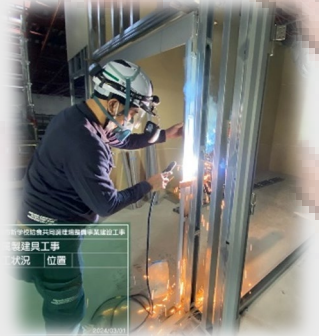
内部ドアの枠取付
