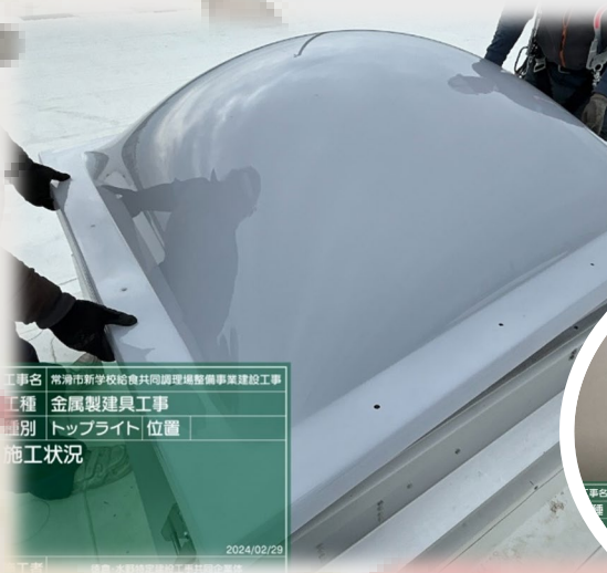
③金属製建具工事（トップライト取付状況）
