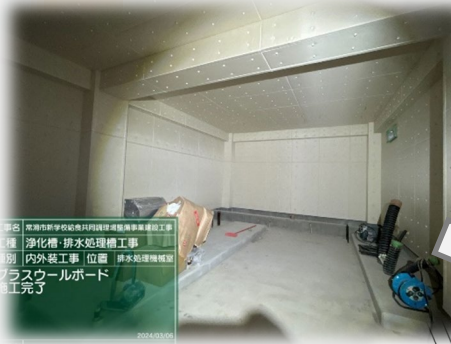
排水処理機械室 グラスウールボード完了！ ↑防音工事だよ！
