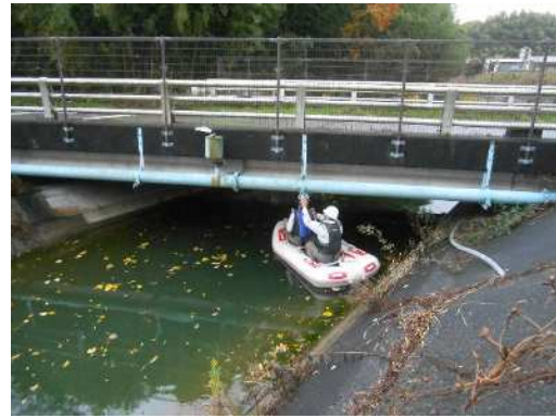
写真-3.2 専門業者による点検状況②
