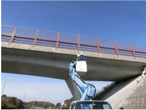
写真-3.1 専門業者による点検状況①
