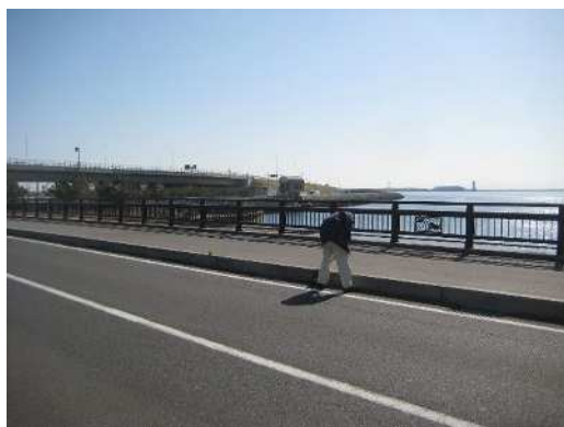
写真-3.3 道路パトロール状況①
