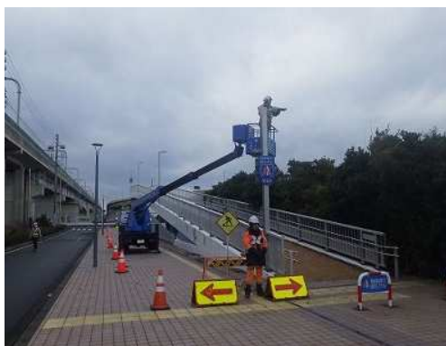
写真-3.1 専門業者による点検状況①
