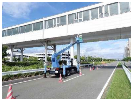
写真-3.2 専門業者による点検状況②
