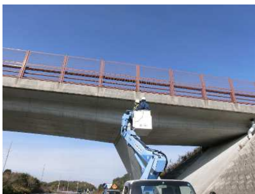
写真-3.1 専門業者による点検状況①
