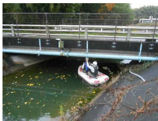
写真-3.2 専門業者による点検状況②
