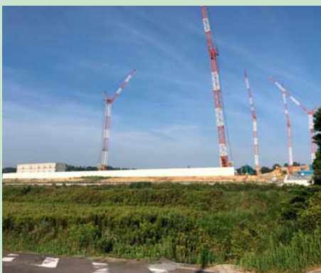
半田運動公園の東に建設中の新半田病院（統合後の知多半島総合医療センター）
