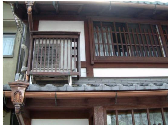
エアコン室外機を木格子で囲った事例
