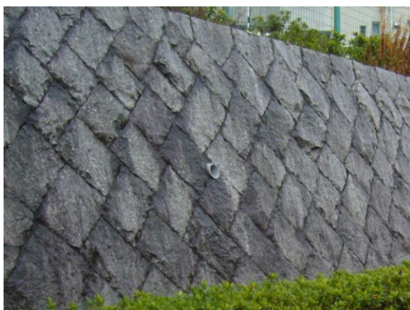
間知石積みの擁壁の事例
