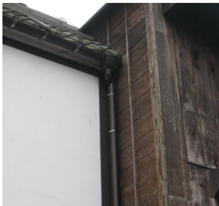
塩ビの とい 樋の事例（外壁及び柱と同系色）
