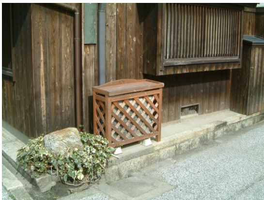
エアコン室外機を木格子で囲った事例
