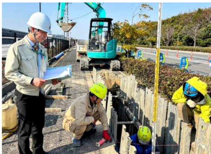
下水道管の据え付け高さ計測の現場立会いの風景
