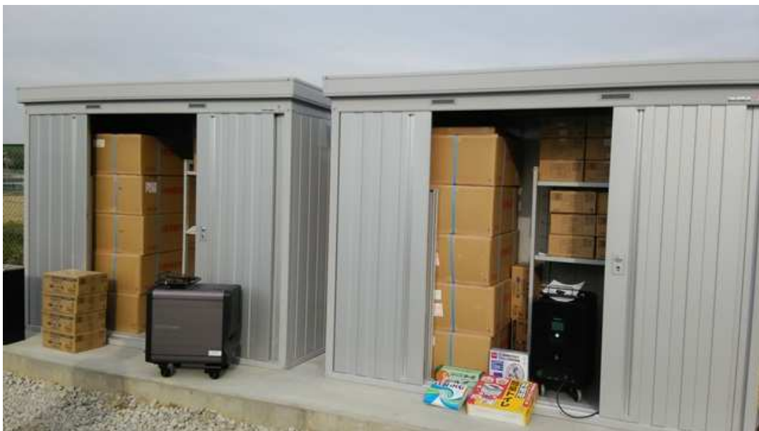
図3 「DREAM Solar 常滑」内の防災備蓄倉庫及び防災用品
