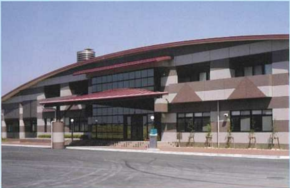
機械の監視、操作や水質の試験をする施設です。
