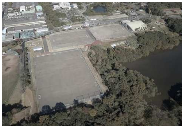
大曾公園グラウンド 完成写真
