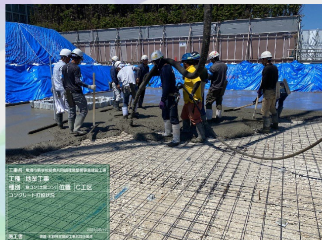
③ 共同調理場棟 捨てコンクリート打設状況
