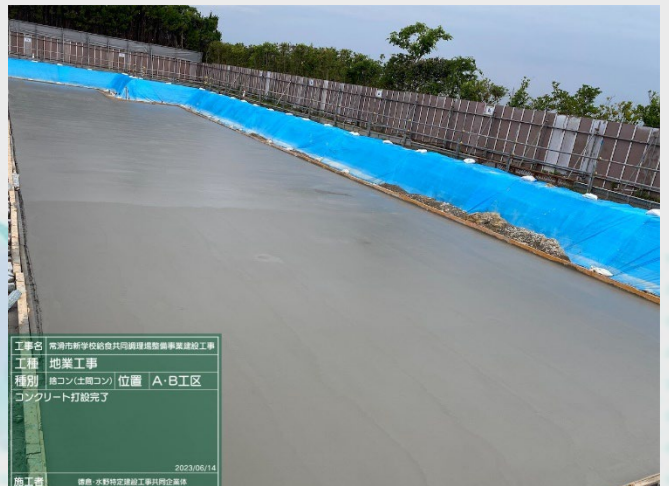
④ 捨てコンクリート打設完了状況
