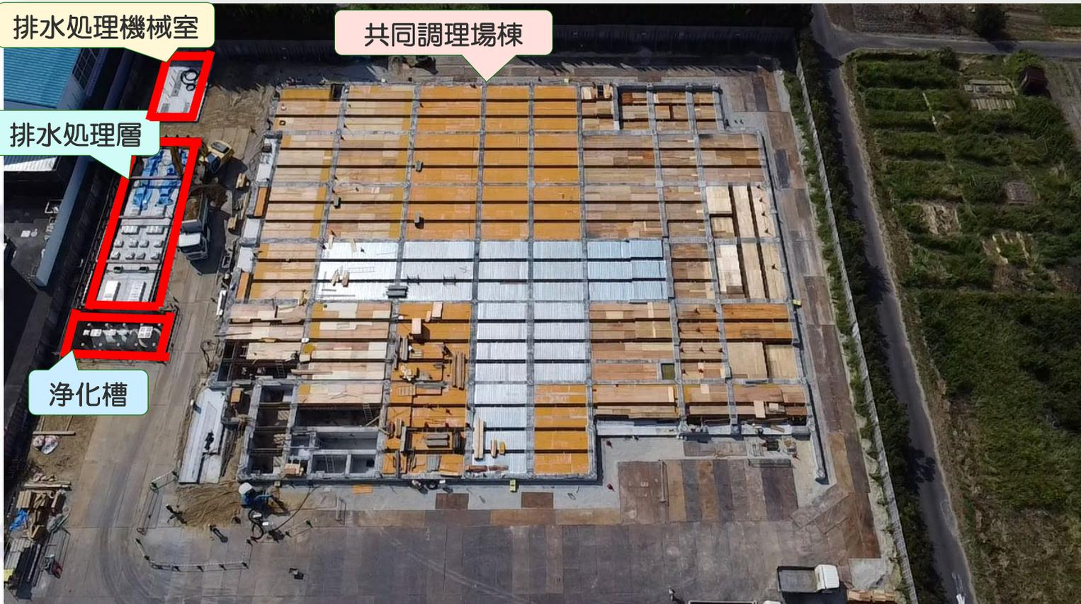
9月の工事内容の紹介します。本体の共同調理場棟の1Fスラブ型枠組を行い同時に共同調理場棟周りの電気設備工事の埋設配管の施工を行いました。排水処理層・浄化槽工事ではコンクリート耐圧板の上にカルバートの据付及び浄化槽の据付を行い、付属棟の排水処理機械室基礎の施工まで完了しています。来月から鉄骨工事が開始されるため、施工前に鉄骨製品検査を監督員、監理者と一緒に行い、鉄骨の製品の寸法、外観等の品質に問題がないか確認検査を行ったよ！
