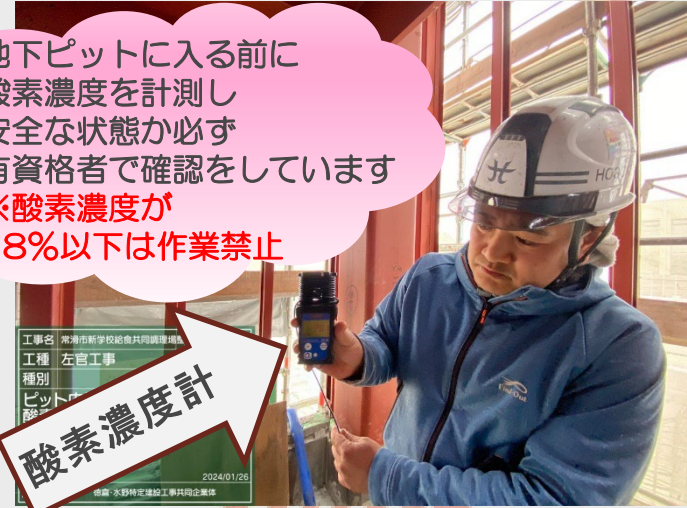
④ピット内工事前の酸欠濃度確認状況
