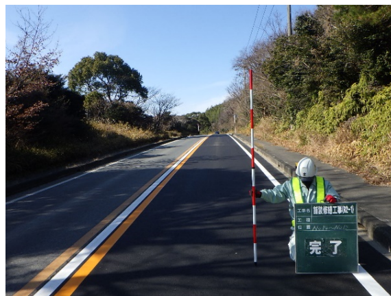
▲舗装修繕工事が完了した道路の様子
