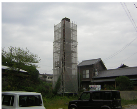
▲改修中の様子
