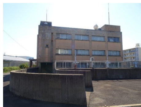
▲榎戸雨水ポンプ場
