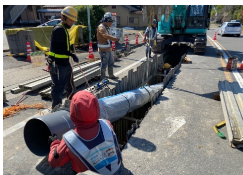
▲配水管の更新・耐震化工事
