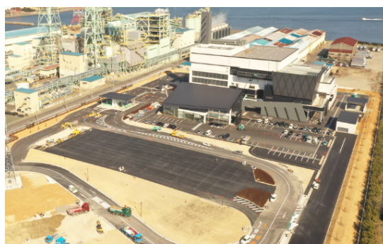
▲知多南部広域環境センター
