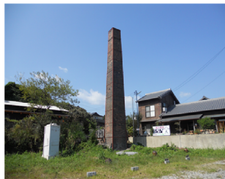
▲改修後のレンガ煙突
