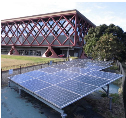
▲太陽光発電施設 (市体育館)
