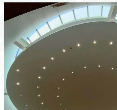
3階 議場自然光を利用するトップライト
