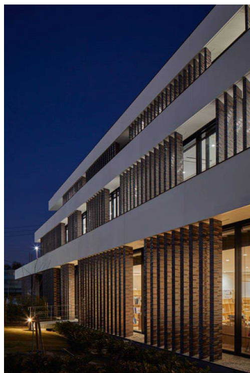
外観（西） 常滑産タイルの日除けルーバー
