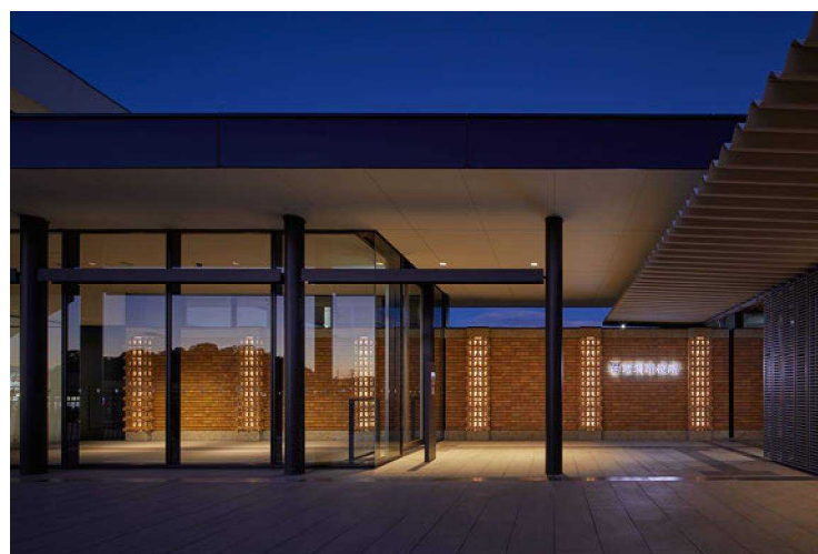
2F スラッチタイル・テラコッタ装飾壁面
