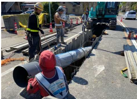
▲配水管の更新・耐震化工事
