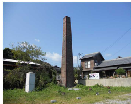
▲改修後のレンガ煙突
