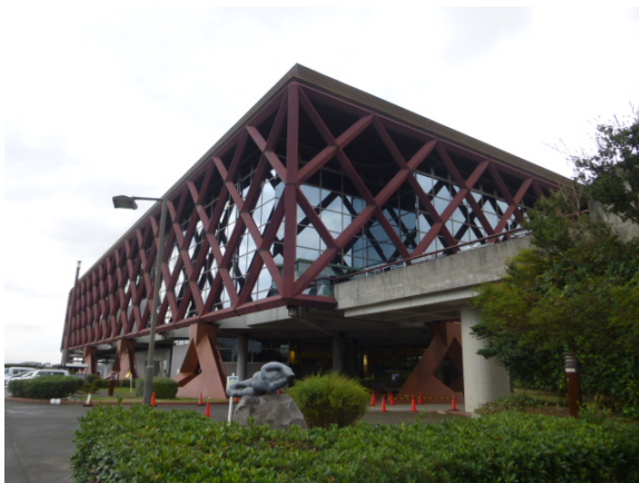
重要給水施設（常滑市体育館）
