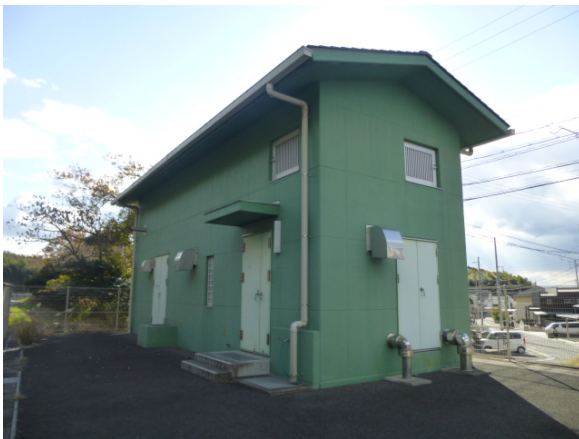
飛香台ポンプ場
