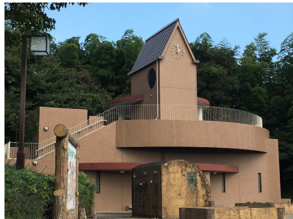
桧原ポンプ場
