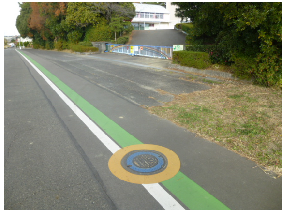
三和小学校に設置済みの応急給水栓（地下式）
