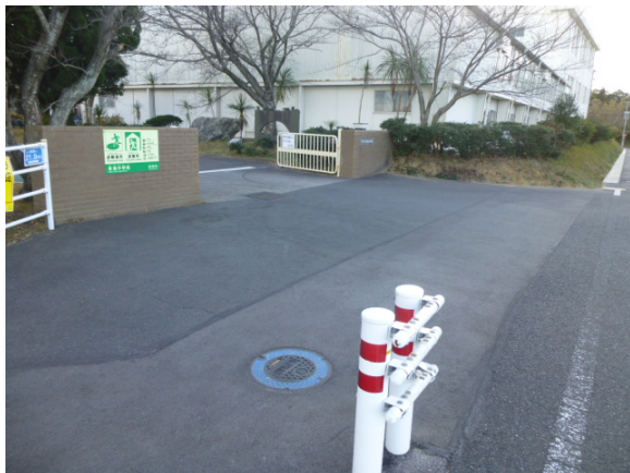
青海中学校に設置済みの応急給水栓（地下式）
