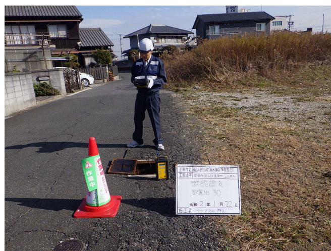
漏水調査風景
