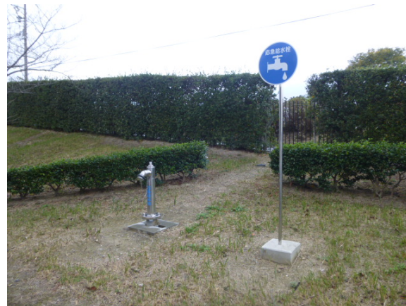
常滑市体育館に設置済みの応急給水栓（地上式）
