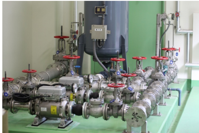
インバータポンプの採用（青海山ポンプ場）
