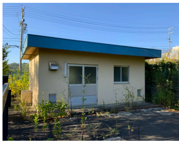
御林ポンプ場
