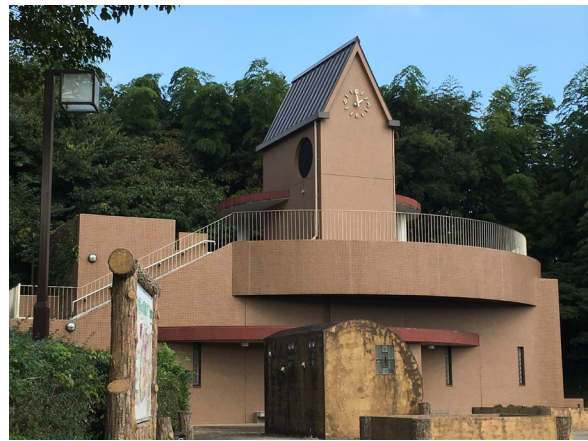
桜原ポンプ場
