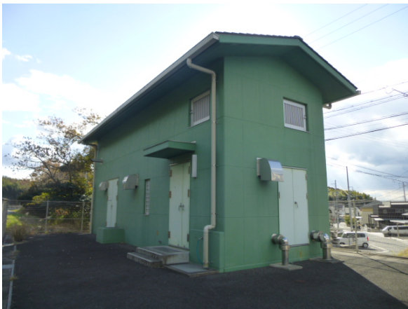
飛香台ポンプ場
