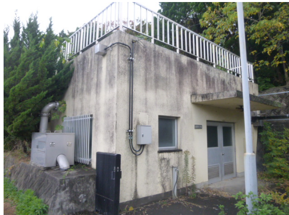
大曾ポンプ場
