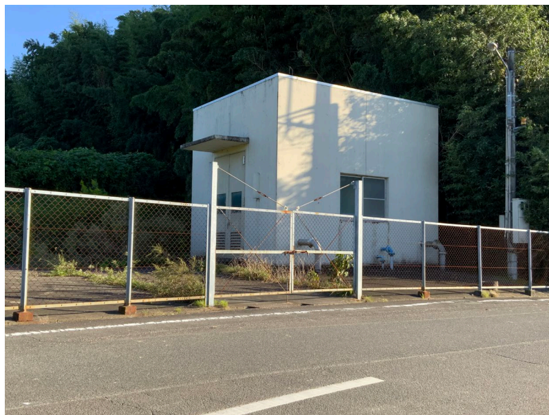
前天神ポンプ場
