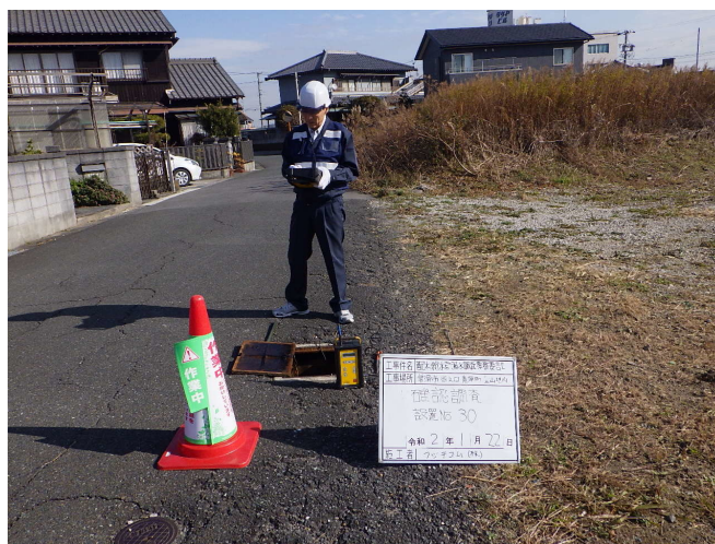
漏水調査風景
