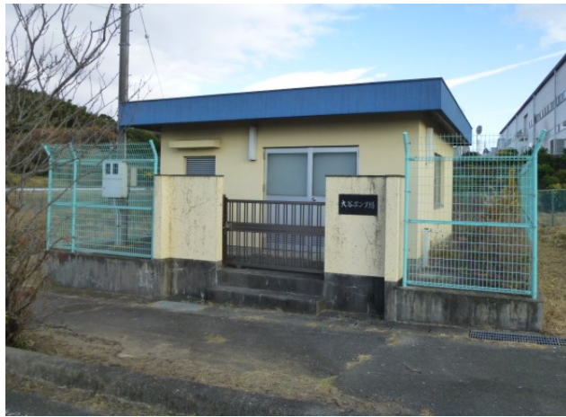
大谷ポンプ場
