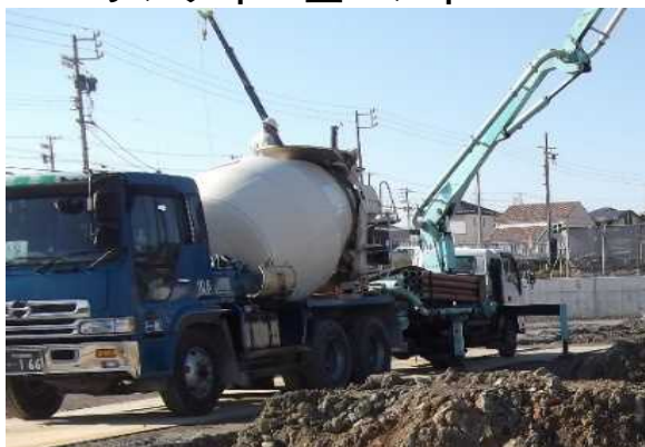
基礎工事・床版工事 ：ポンプ車・生コン車
