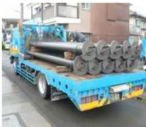
杭等搬入：10 tトラック
