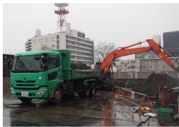
基礎工事：ダンプ
