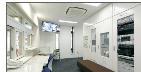
【エネルギー管理システム】
