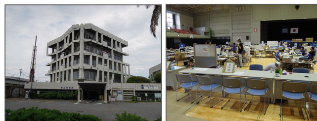
【被災した市庁舎】
