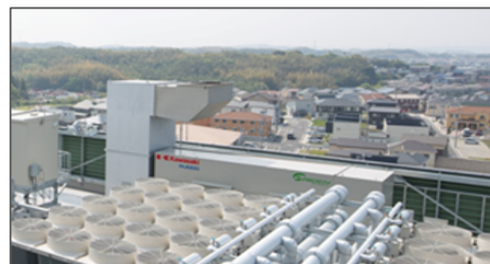
【自家発電装置】
