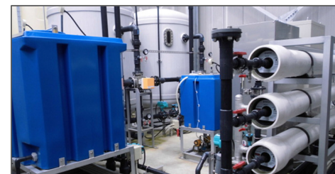
【地下水供給設備】
