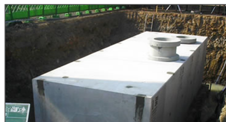
【災害用汚水槽】
