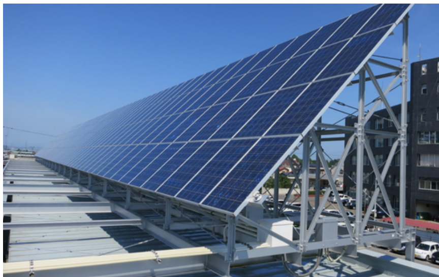
☑ 図12 太陽光発電パネル
