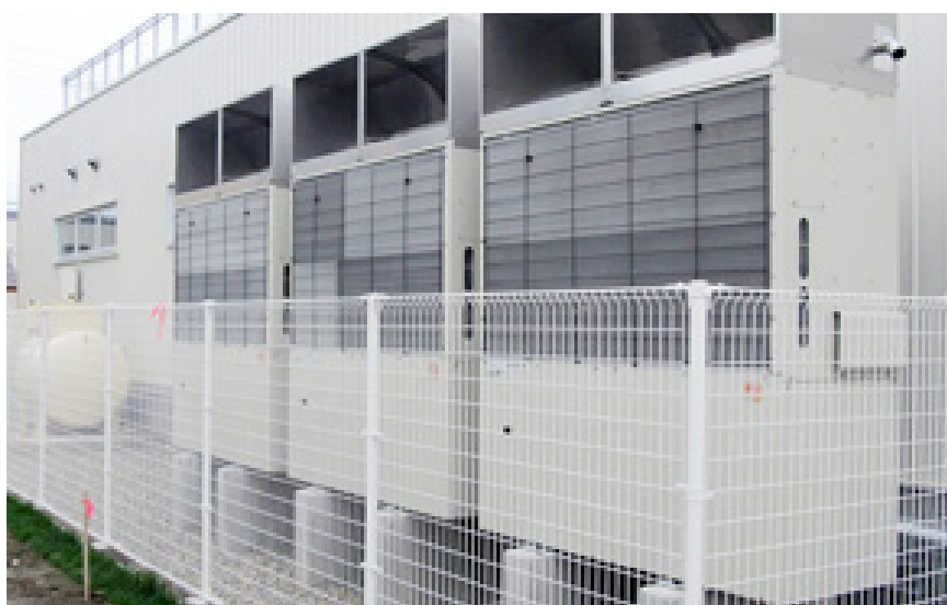
📷 図11 電源自立型空調設備
