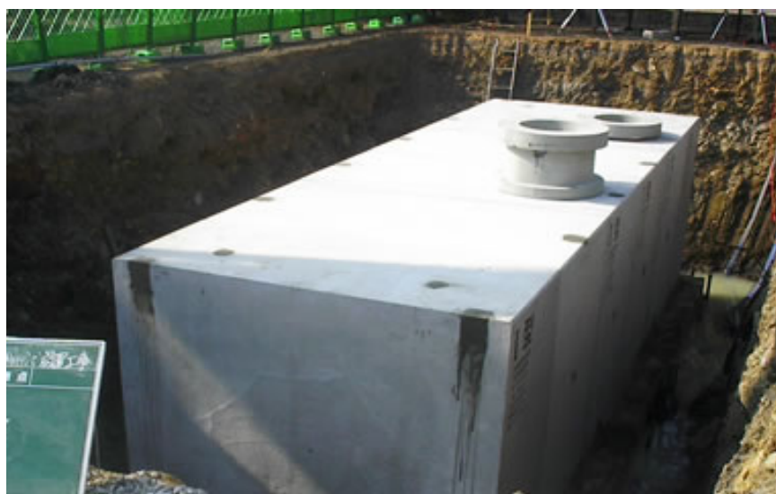
📷 図9 緊急用汚水槽
