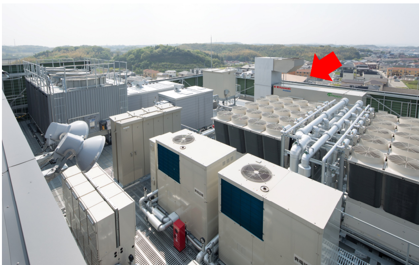
📷 図3 非常用発電機
