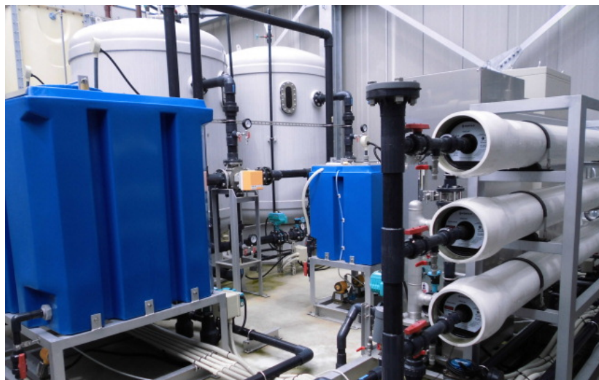
📷 図8 地下水供給設備
