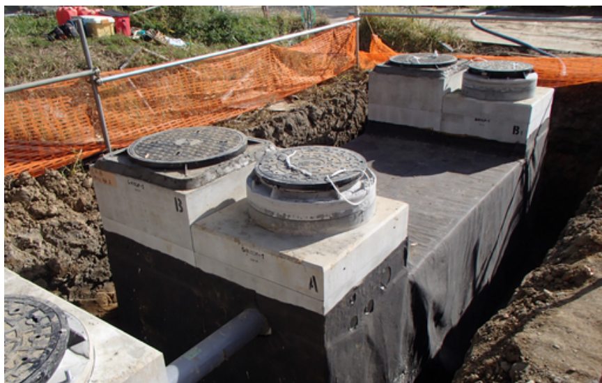
📷 図10 雨水貯留槽
