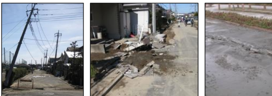
図6 液状化被害 (埼玉県久喜市)
