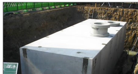
【災害用汚水槽】
