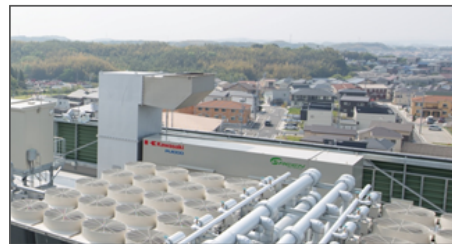
【自家発電装置】
