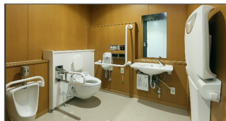
【多目的トイレ】
