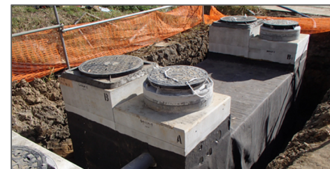
【雨水貯留システム】
