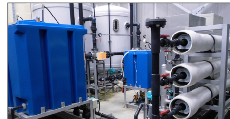
【地下水供給設備】
