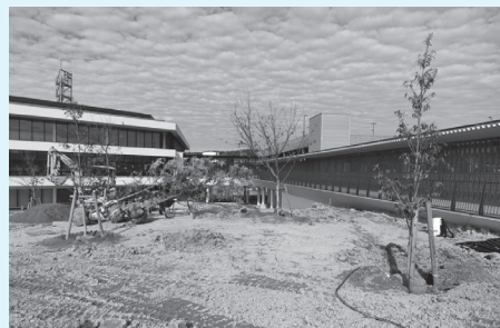
▲外構工事の状況（9月20日時点） 引き続き埋設配管の敷設工事を行うとともに、植栽工事を行っています。
