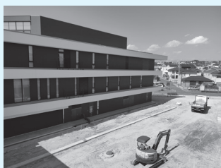
◀外構工事（8月30日時点） 建物周りの造成や排水 管の工事を行っています。
