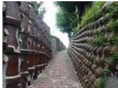
焼き物を使った道、擁壁
