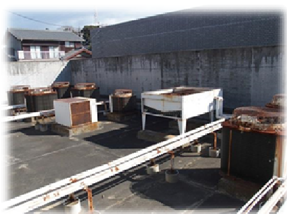
空調設備の老朽化
