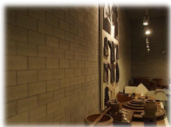
大地震時にC B（コンクリートブロック）壁 崩落の危険有
