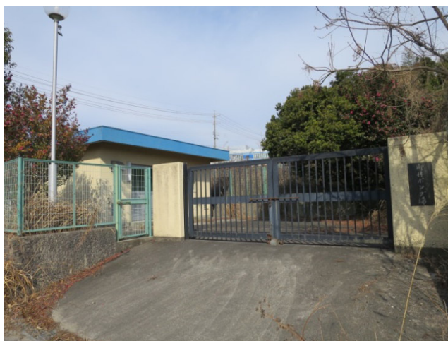
御林ポンプ場
