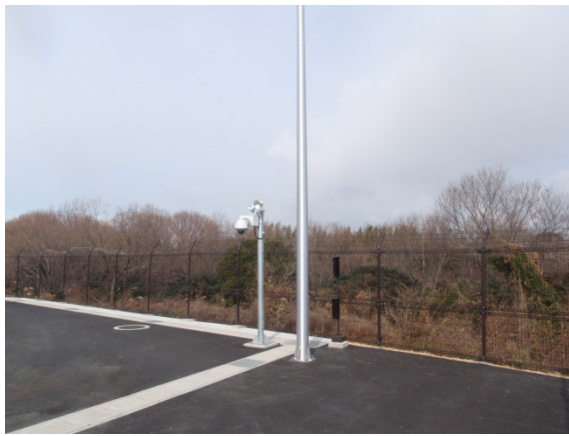
監視カメラ (久米配水場)
