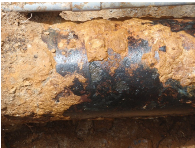
老朽管の外観
