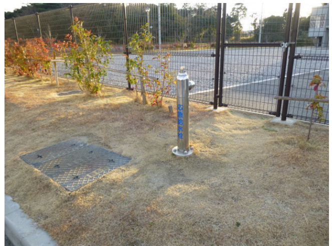
消防本部に設置済みの応急給水栓（地上式）
