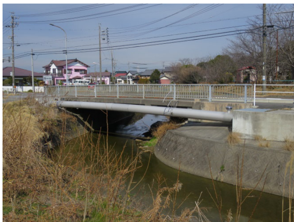
水管橋 (久米配水区)
