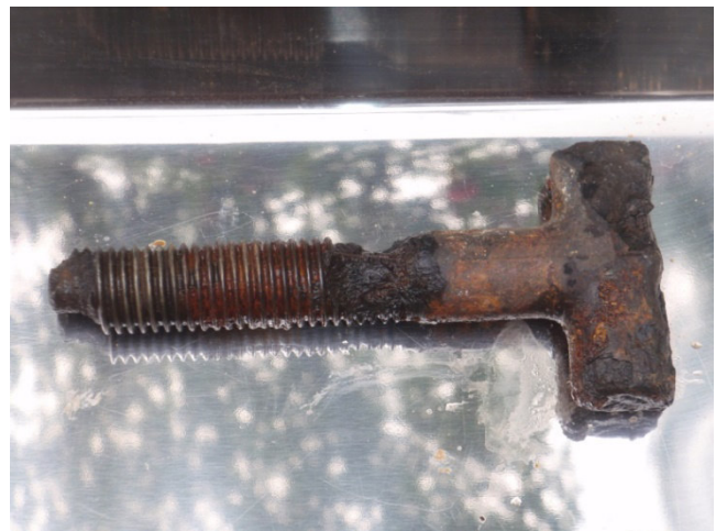
腐食したボルト
