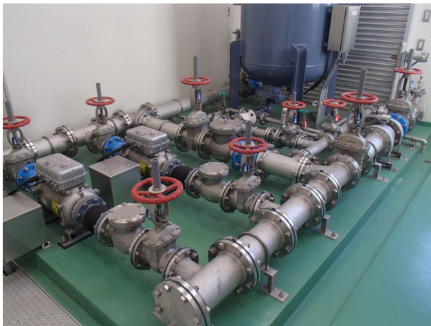
インバータポンプの採用 (青海山ポンプ場)
