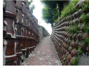
■焼き物を使った道、擁壁
